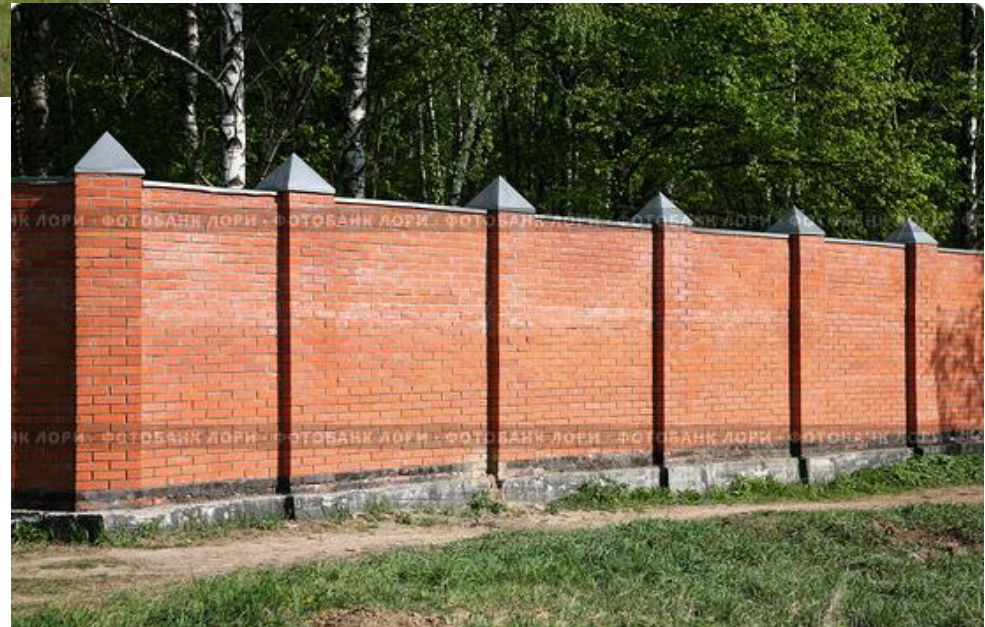
В виде сплошной кирпичной кладки. Пункт 3.2
