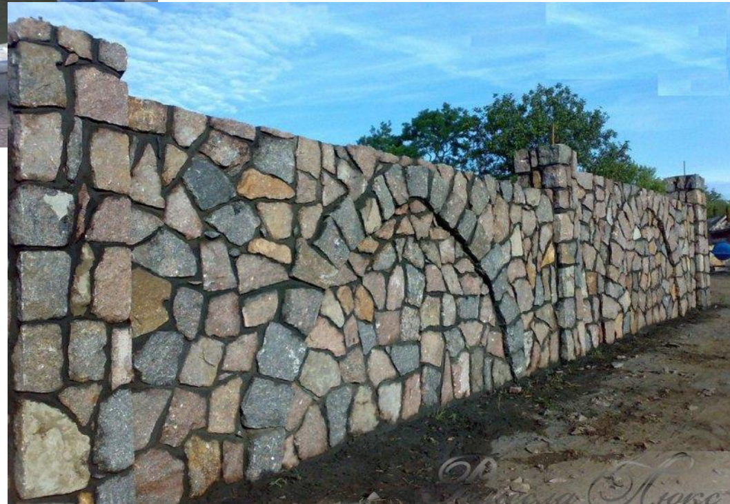
Облицованные необработанным натуральным камнем Пункт 3.6
